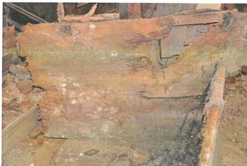
Slika 8: Pri demontaži oltarja smo ugotovili, da je bil les zaradi vlage na spodnjih delih oltarjev, povsem preperel.
